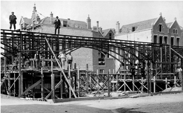
Hofpleinviaduct in aanbouw in 1904
