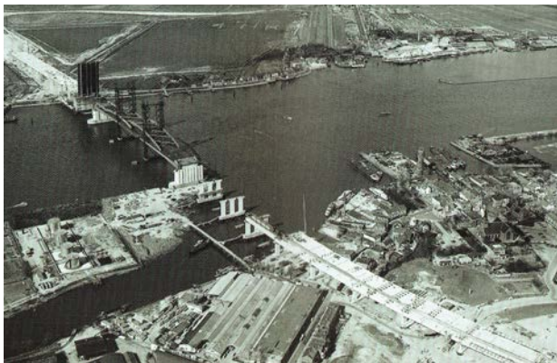
Aanleg Van Brienoordbrug, Rotterdam
