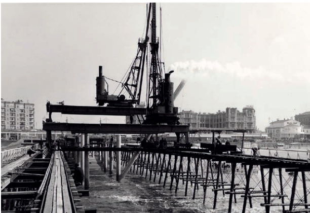
Bouw Pier, Scheveningen
