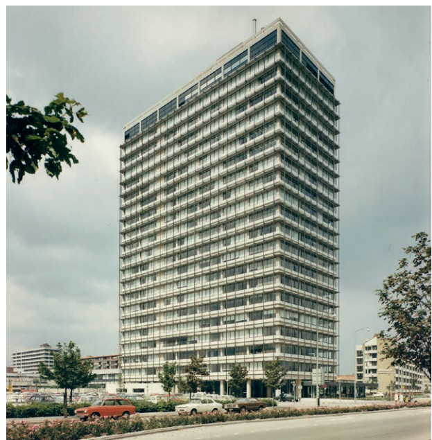
Jackblock gebouw L, Rijswijk
