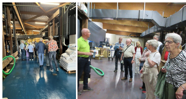
In de technische ruimten van de Ocean
