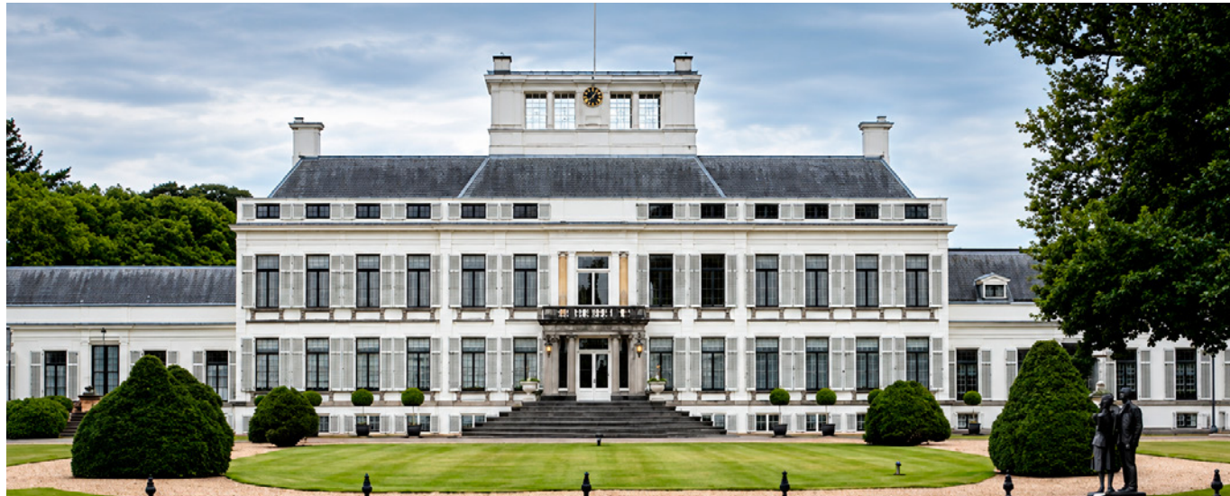
Paleis Soestdijk, verbouwd door BAM
