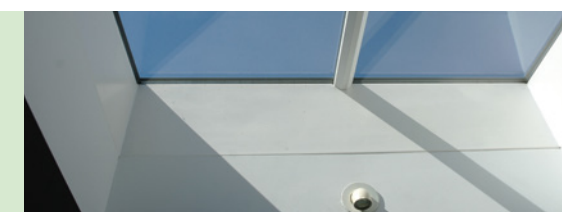
Bovenlichten in kamers en gang waardoor er meer licht in huis valt.
